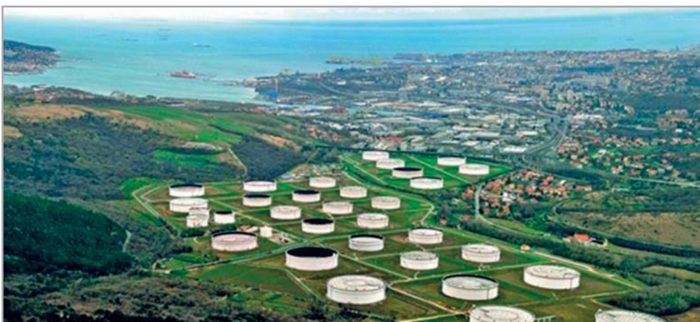
Figura 1 - Vista aerea del parco serbatoi SIOT
