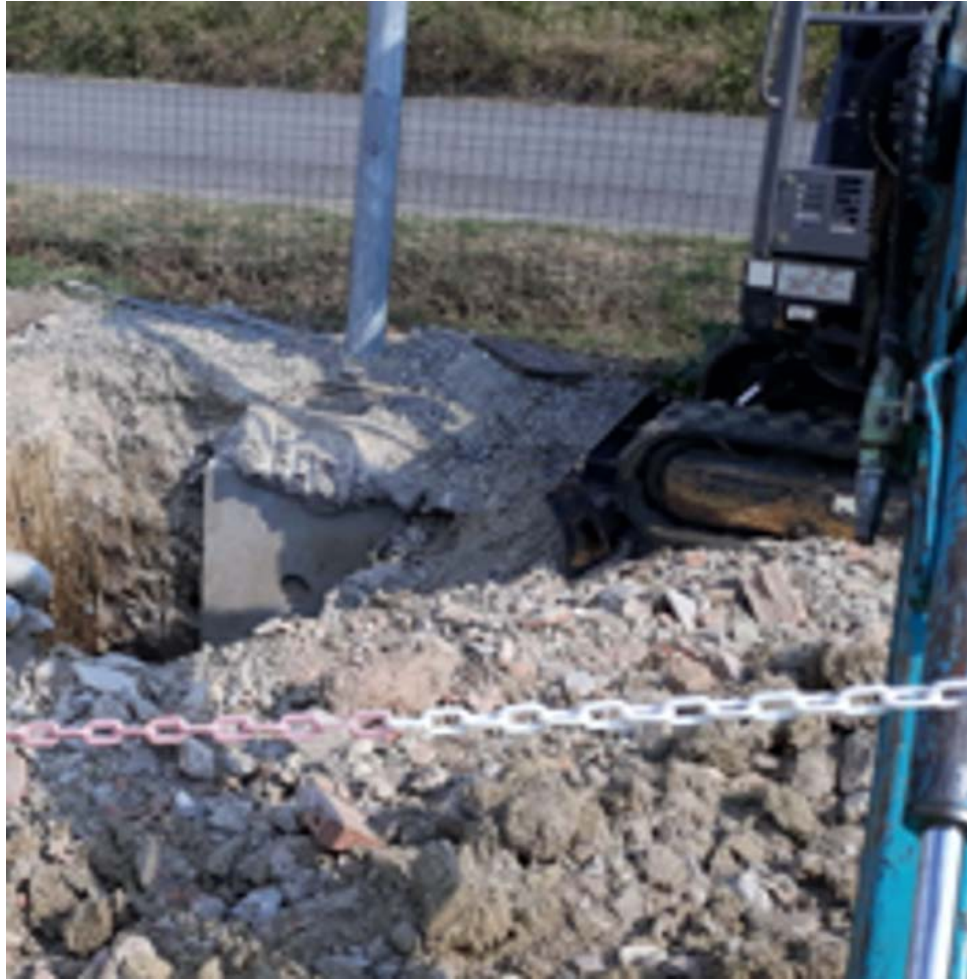
Fig. 14 - Momenti del ripristino del danneggiamento.
